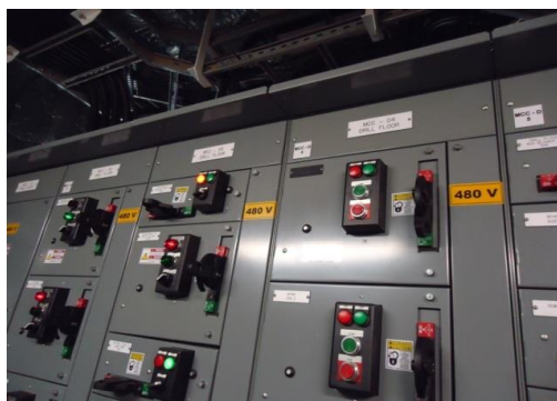
FIGURA 16 – CENTRO DE CONTROLE DE MOTORES - CCM
