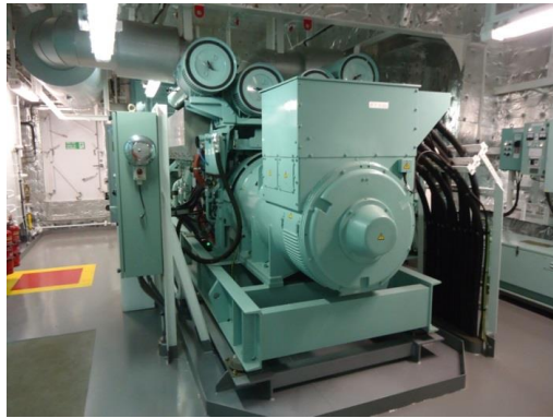
FIGURA 15 – GERADOR DE EMERGÊNCIA
